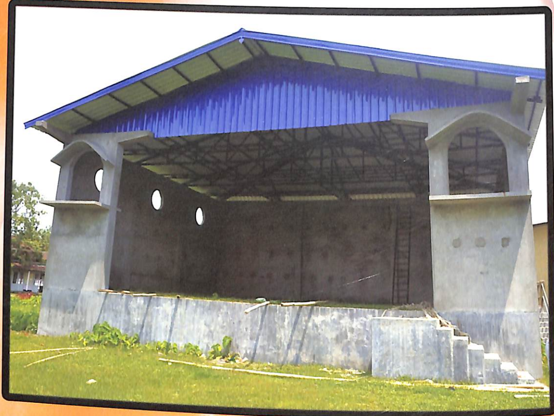
নবনির্মিত বৃহৎ মুকলি মঞ্চ
